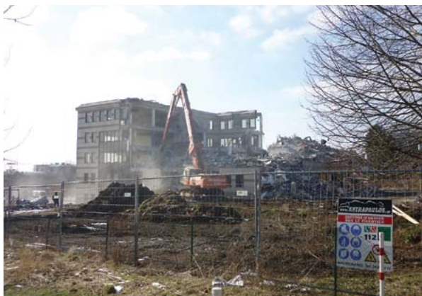
Travaux de démolition
