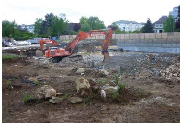
Travaux de terrassement
